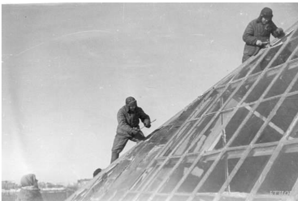
Приложение 10. Таврический дворец. Заделка поврежденного светового фонаря над центральным залом фанерой и тонкой жестию. 1943 год. Фото ТАСС
