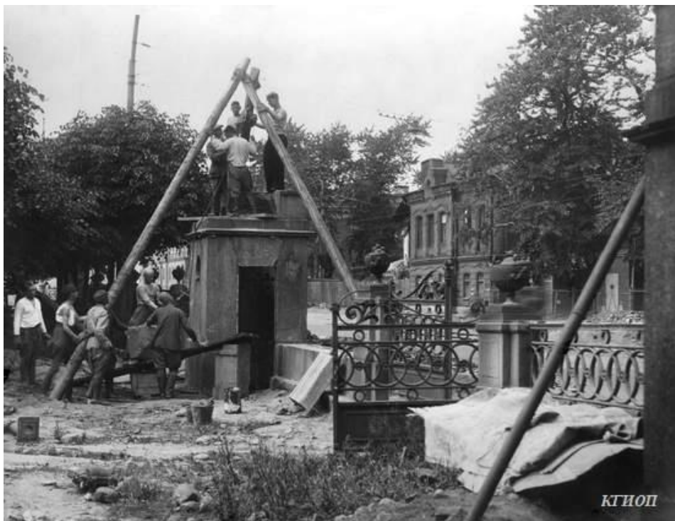
Приложение 12. Восстановление ограды Таврического дворца, разрушенной фугасной бомбой. 1943 год Фотограф А.К. Григорьев
